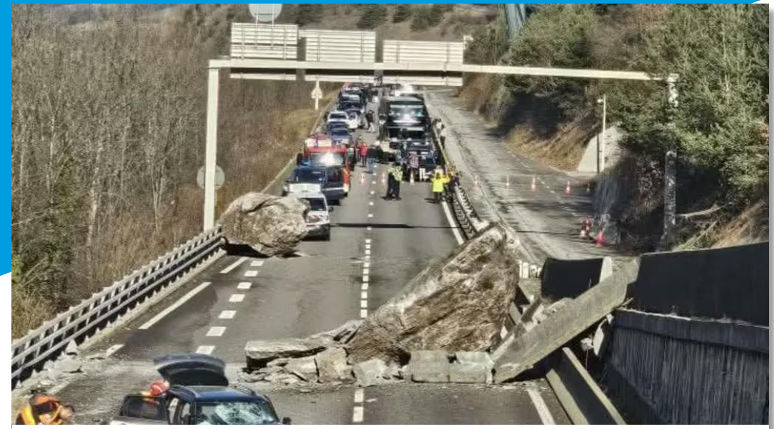
Éboulement entre Albertville et Moûtiers (Savoie, 2025)
